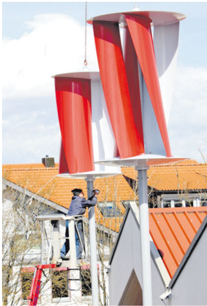
Das gut zwei Meter hohe Mini-Windrad „Wind of Change“ wird in Bayern an ein Hausdach montiert. Foto: privat
